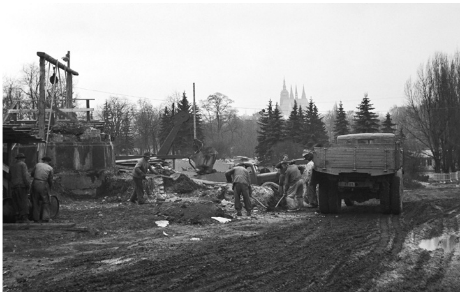
Obr. 11 Výkopy pro mohutný fundament Stalinova pomníku, označovaný pro svůj půdorys i v oficiální stavební dokumentaci – v soudobém kontextu studené války velice pitoreskně – jako pentagon . V pozadí snímku jsou patrné montované budovy pracovního tábora; 28. březen 1952 (© ČTK / Skalický Stanislav)
