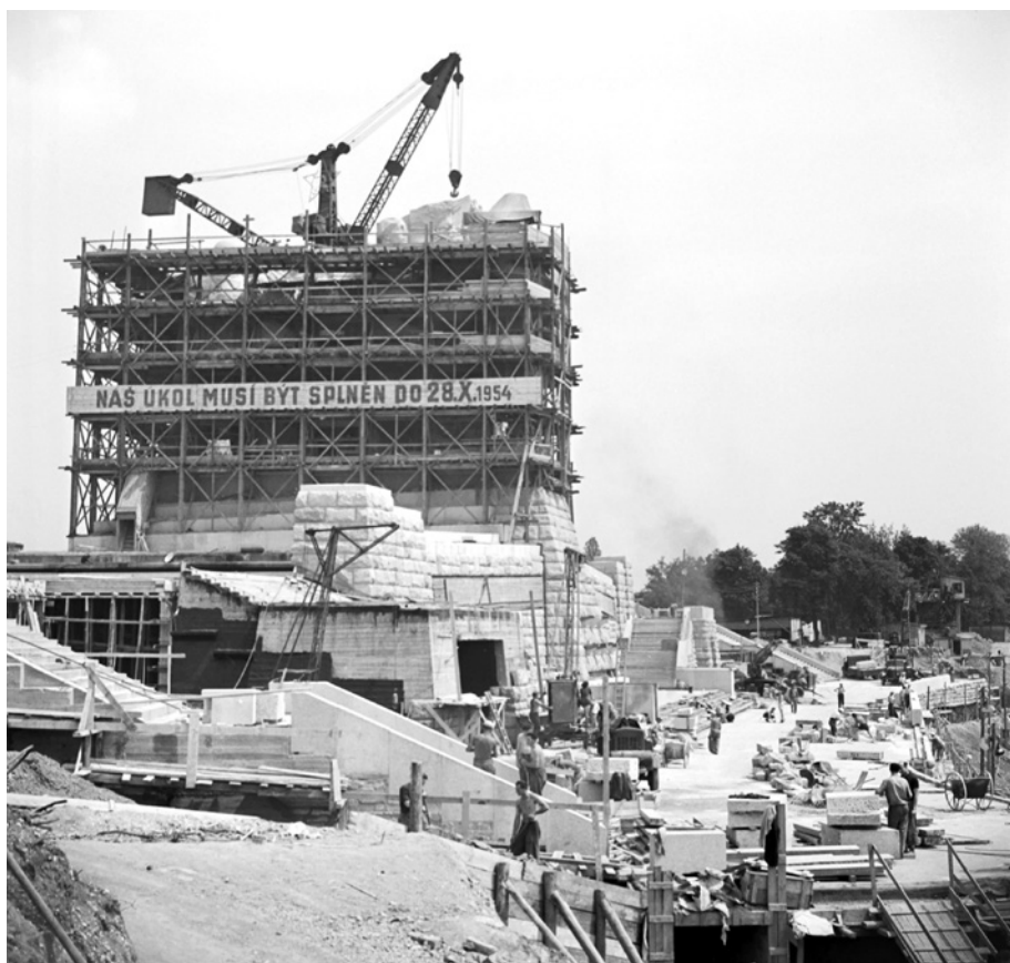
Obr. 12 Stavební úsilí vrcholí. Na železobetonové jádro pomníku jsou usazovány kamenosochařské prvky, zároveň již probíhají i parkové úpravy v bezprostředním okolí; 17. červen 1954 (© ČTK / Nebor Leoš, Hampl Alexandr)
